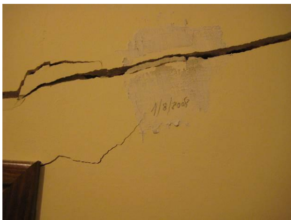
Figura 6: Cimentación en terreno expansivos: fisuras
